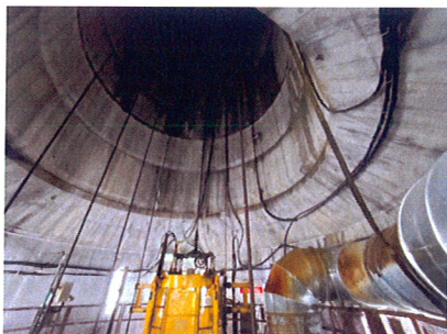
垂直坑道。キブルと呼ばれるカゴ状のエレベーターに乗って昇降する。
